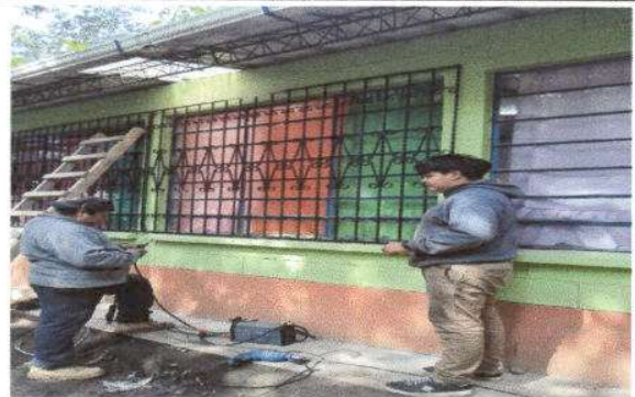
Foto 14: Fabricación e instalación de balcones de hierro en ventanas en módulo 2
