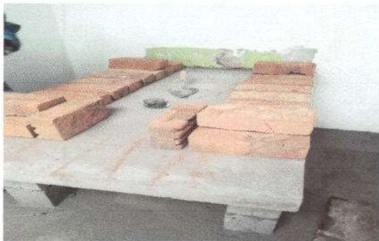
Foto 15: Sustrucción de estufa rural en cocina.
