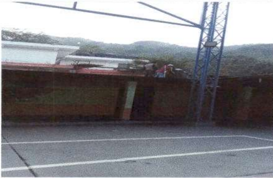
Foto 13: Sustrucción de depósito de agua 1,700 lts.
